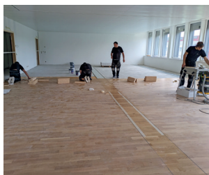
Campus CSCSP - posa del parquet nella sala dei seminari
