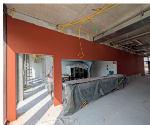
Campus CSCSP - pittura del refettorio
